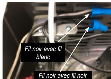
**REMARQUE :** Débrancher les raccords existants sur le moteur du ventilateur et les dénuder pour dégager les fils avant de les brancher.
