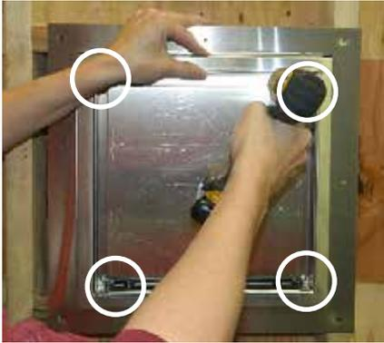
11. Dévisser les 4 vis dans les emplacements indiqués ci-dessous, soulever la gouttière pour la dégager (fentes en forme de trous de serrure).
