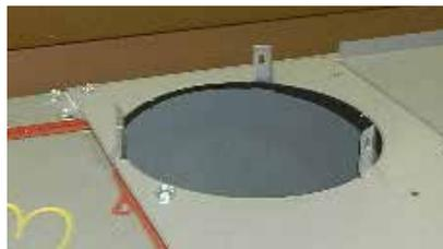
4. Connecter l'adaptateur du conduit à l'aide de 3 vis (utiliser les trous inférieurs situés sur l'adaptateur).
