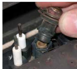
16. Dévisser l'orifice de la veilleuse à l'aide d'une clé hexagonale Allen; puis le remplacer par l'orifice de la veilleuse et le capuchon de la veilleuse, pour propane fournis dans la trousse.
