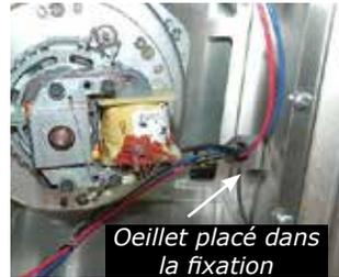
15. Connecter le fil de terre à la prise de terre située à l'arrière du boîtier Power Vent.
