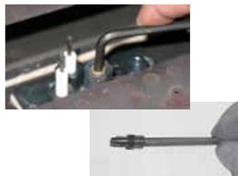
17. Réinstaller le capuchon de la veilleuse et la pince de retenue de la veilleuse.
