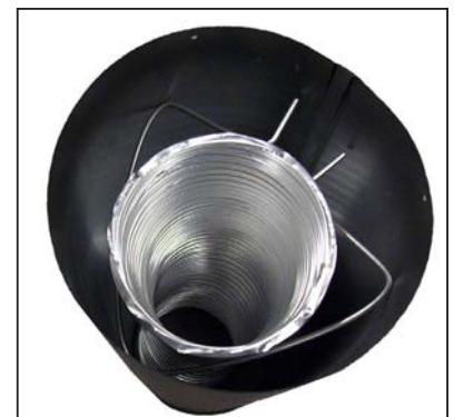
Figure 20.2: entretoises de fil en place
