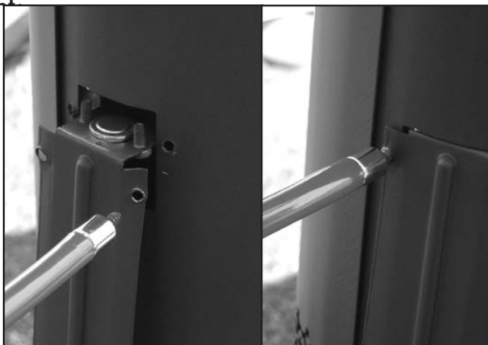
Figure 49: installation de l'interrupteur d'écoulement
