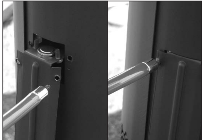
Figure 47: Installation de l'interrupteur d'écoulement
